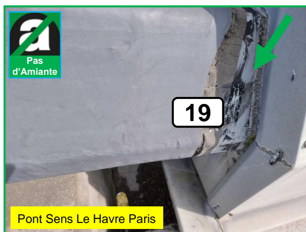
P21 Peinture bitumineuse Socle béton Selle : Absence de fibre d'Amiante
