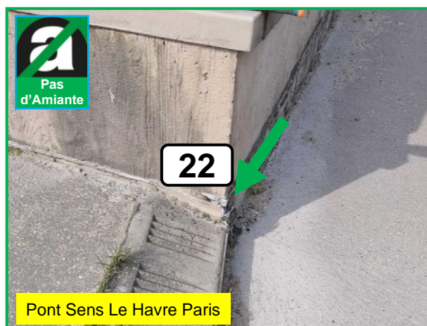
P24 Peinture bitumineuse Collier de serrage : Absence de fibre d'Amiante
