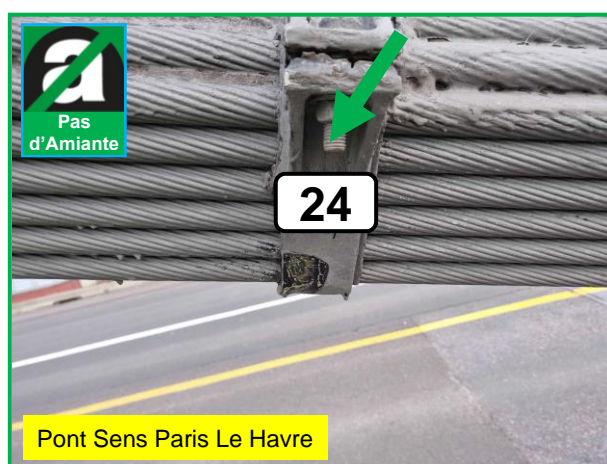
P24 Peinture bitumineuse Collier de serrage : Absence de fibre d'Amiante
