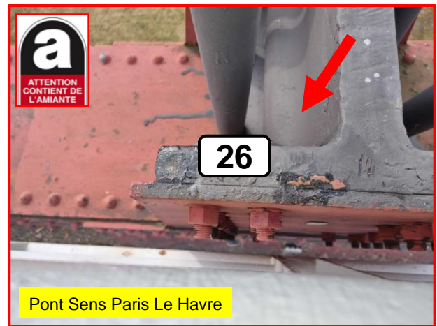
P28 Peinture bitumineuse Suspent : Absence de fibre d'Amiante
