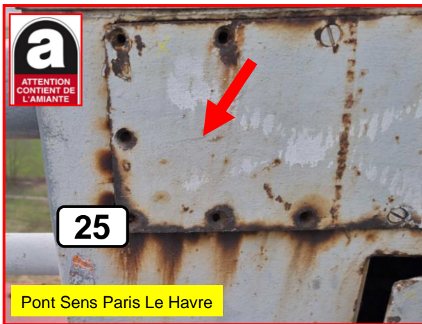
P27 Mastics bitumineuse Ecou Suspente : Absence de fibre d'Amiante
