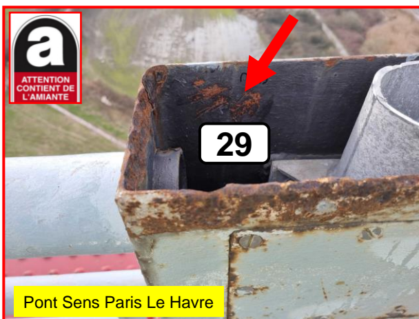
P29 Peinture + Sous couche Armoire : Présence de fibre d'Amiante Chrysotile
