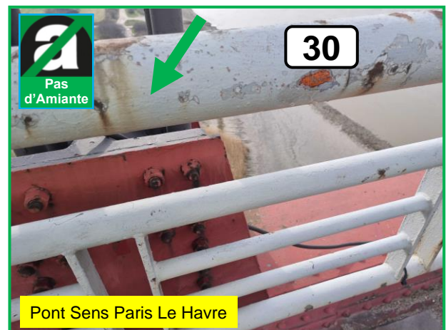
P30 Peinture bicolore + Sous couche Main Courante : Absence de fibre d'Amiante
